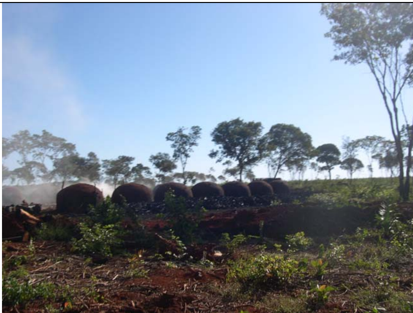
Figura 25 – Vista geral da área de cerradão na All em processo de desmate e carvoejamento
