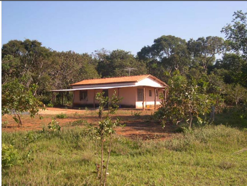
Figura 25 – Construção na margem direita do braço do reservatório.
