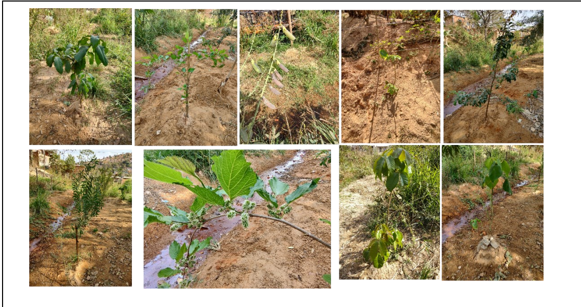
Fig. 02 – Recuperação das nascentes, da vegetação e melhorias na drenagem
