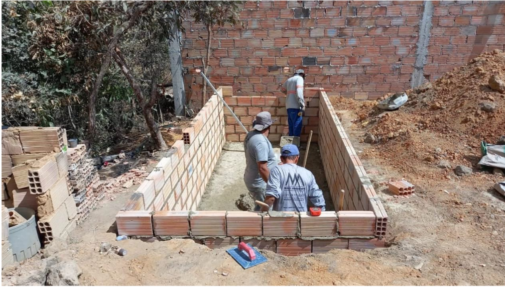
Fig. 8 - Vista da construção das paredes de alvenaria da fossa de um TEVap na rua Felicidade, Comunidade Vitória – Projeto Izidora. Fonte: MAIS AMBIENTE.
