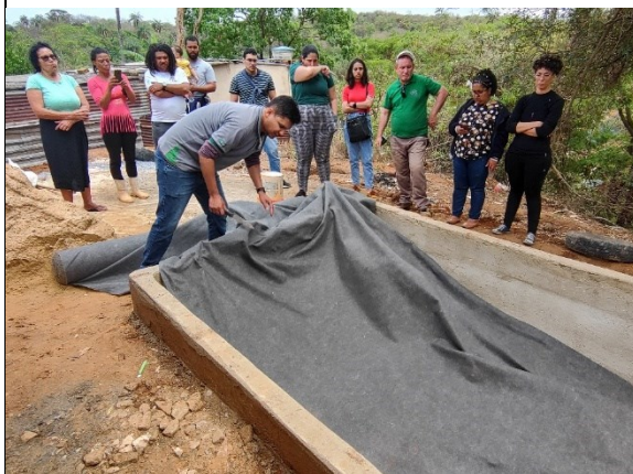
Fig. 16 D -Moradores conferindo a colocação da primeira camada de pedra de mão com a tela mosquiteiro para logo preencher com uma camada de areia. Fonte: MAIS AMBIENTE.
