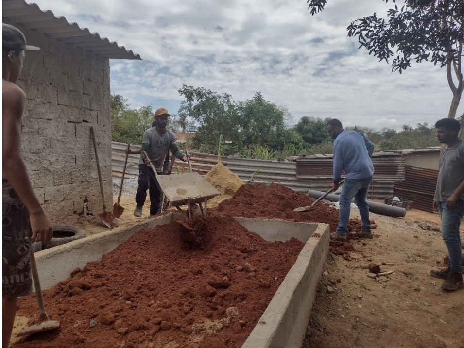
Fig. 14 – Adição da camada de solo orgânico no TEVap da Cozinha Comunitária como parte da oficina demonstrativa. Fonte: própria
