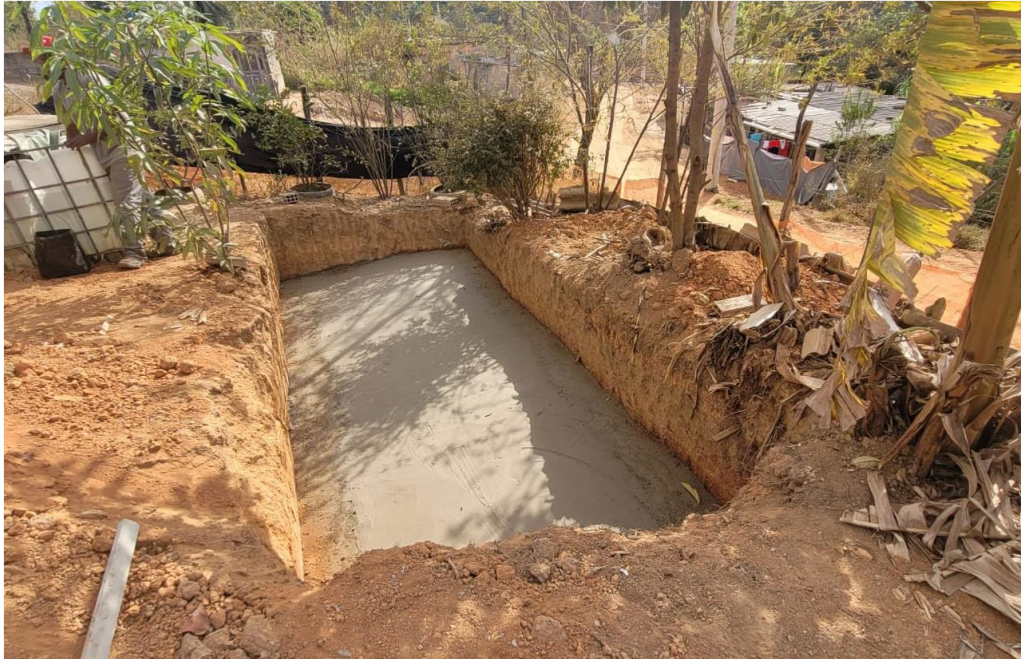
Fig. 7 - Vista da concretagem de fundo da fossa de um TEVap na rua Carolina de Jesus, Comunidade Vitória – Projeto Izidora. Fonte: MAIS AMBIENTE.
