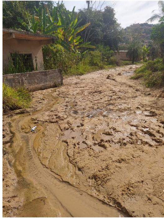
Foto 7.2 – Acúmulo de sedimento nas vias devido ao desvio do escoamento.
