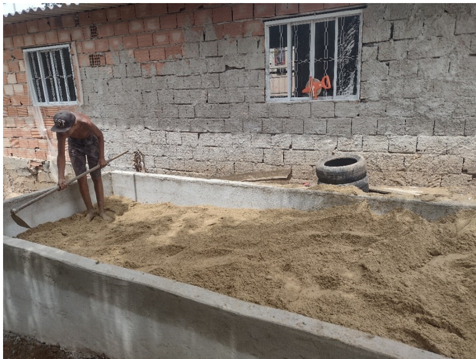
Fig. 13 – Adição da camada de areia no TEVap da Cozinha Comunitária como parte da oficina demonstrativa. Fonte: própria.
