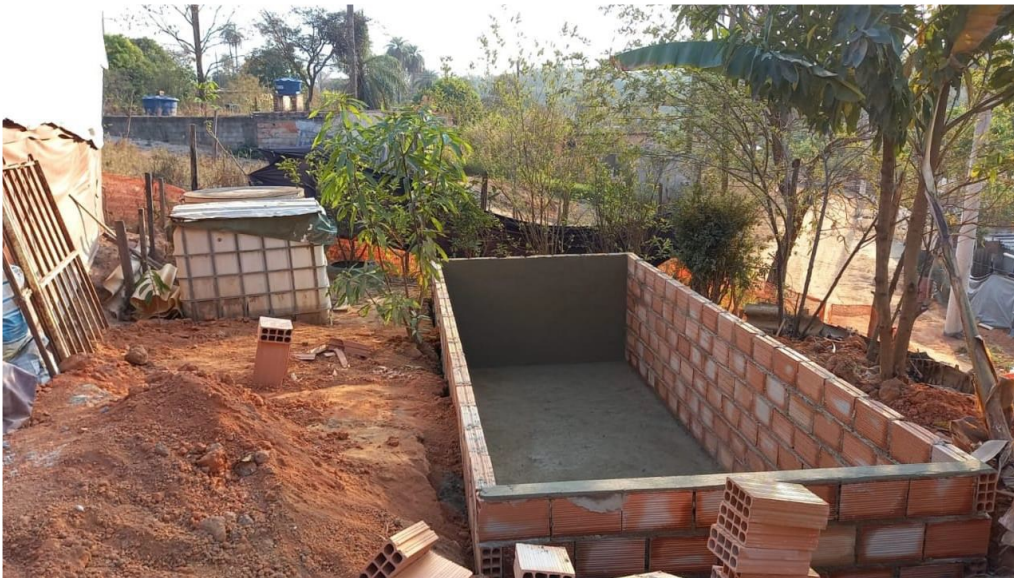
Fig. 9 - Vista das paredes da fossa de um TEVap sendo rebocadas com massa forte e aditivo de impermeabilizante na rua Carolina de Jesus, Comunidade Vitória – Projeto Izidora. Fonte: MAIS AMBIENTE
