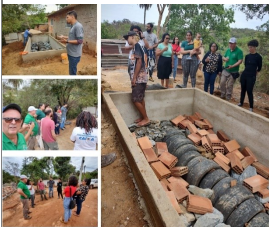
Fig. 16 A - Vista do tanque rebocado e impermeabilizado pronto para ser preenchido na atividade socioambiental na presença de moradores e convidados. Fonte: MAIS AMBIENTE
