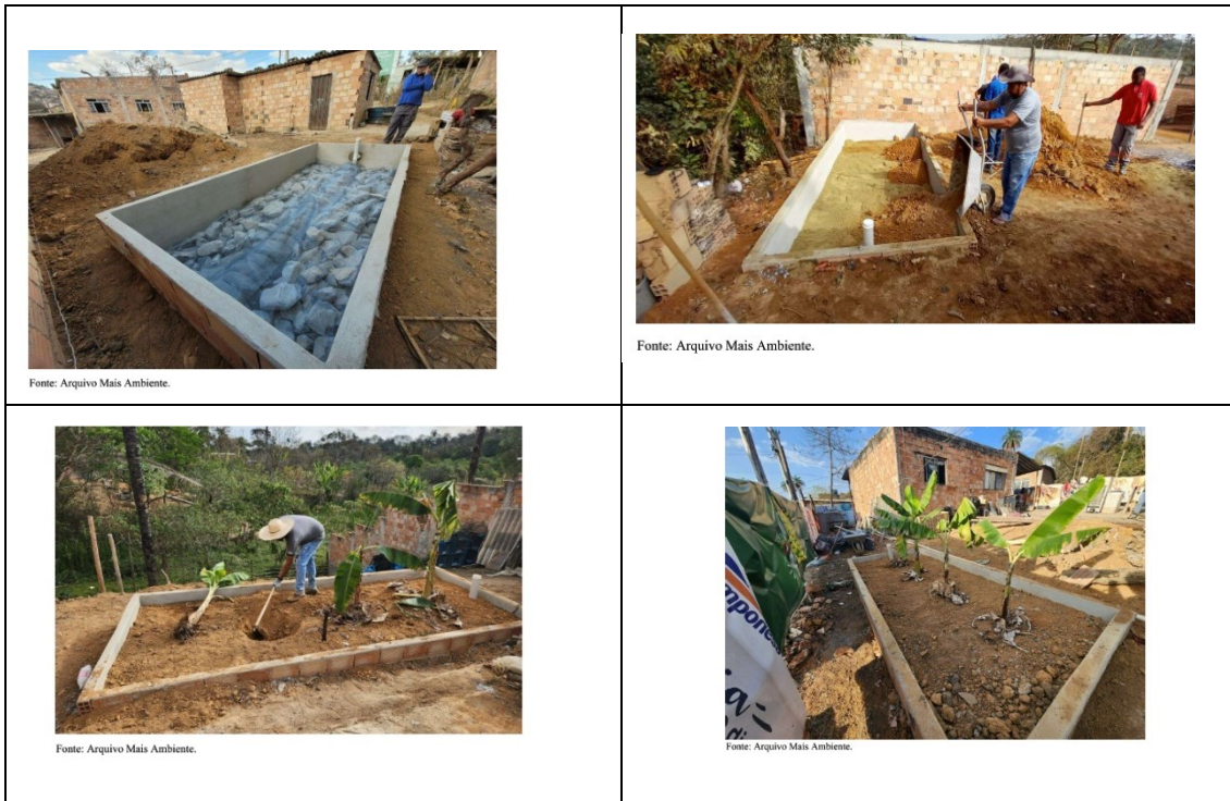
Fig. 05 - Fases da construção de um TEVap.
