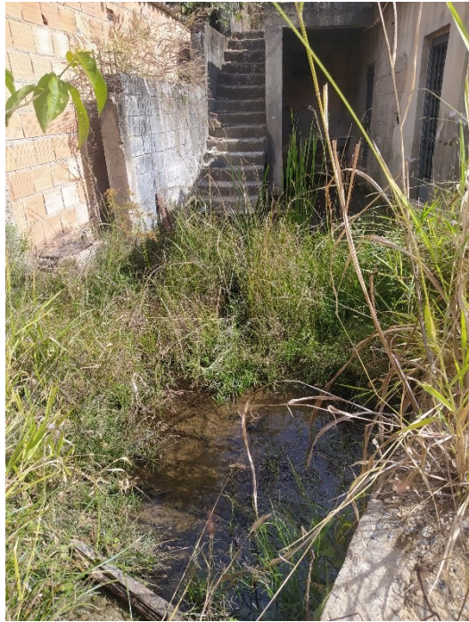
Foto 7.1 – Água escoada para dentro de uma residência na comunidade.
