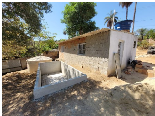
Fig. 16 A - Vista do tanque rebocado e impermeabilizado pronto para ser preenchido na atividade socioambiental na presença de moradores e convidados. Fonte: MAIS AMBIENTE
