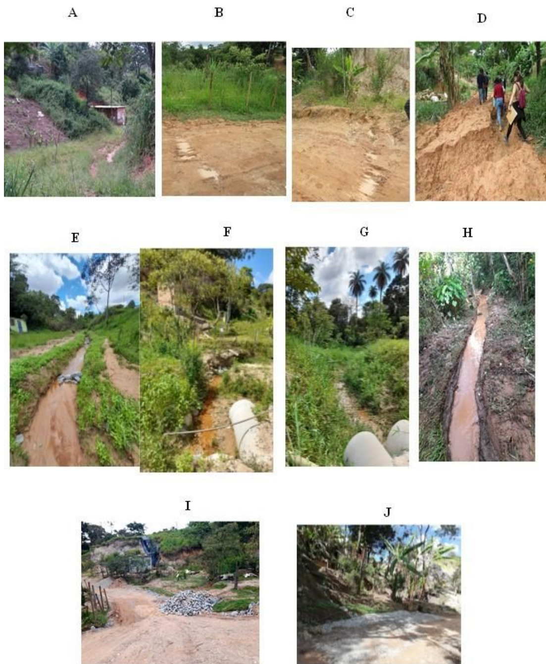
Fig. 4 - Nascente N1: Antes da intervenção: A : Nascente na rua correndo em diferentes direções (N1-A). B : Nascente aflorando na rua. C : Nascente aflorando na rua. D : Erosão (N1-A). Após da intervenção: E : Dreno recebendo água da nascente. F : Manilha antes da rua (N1-A). G : Nascente após a rua (N1-C). H : Dreno na N1-C. I e J : Aspecto da rua após intervenção.
