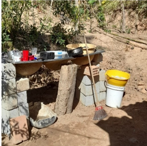
Fig. 6 – Lançamento do efluente de tanque/pia diretamente no solo. Fonte: Original.
