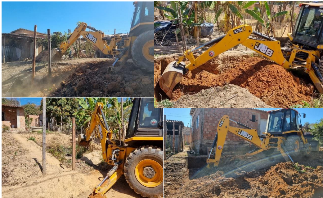
Fig. 6- Construção da fossa dos TEVap (2 x 1 x 4 metros) usando uma retroescavadeira. Fonte: MAIS AMBIENTE.
