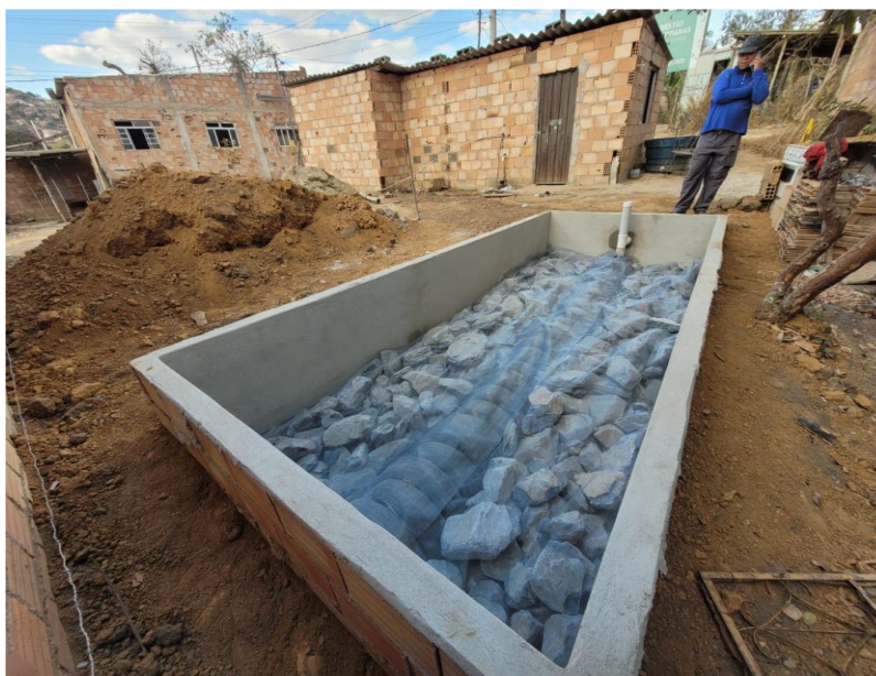
Fig. 11 - Preenchimento do TEVap com pedra de mão, instalação do piezômetro e da tela mosquiteiro. Fonte: MAIS AMBIENTE.
