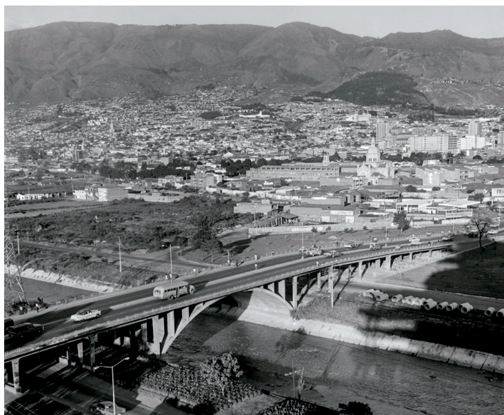
Fig. 3 - Canalización del Río Medellín. Fuente: León Francisco Ruiz Flórez, Archivo fotográfico Biblioteca Pública Piloto de Medellín.
