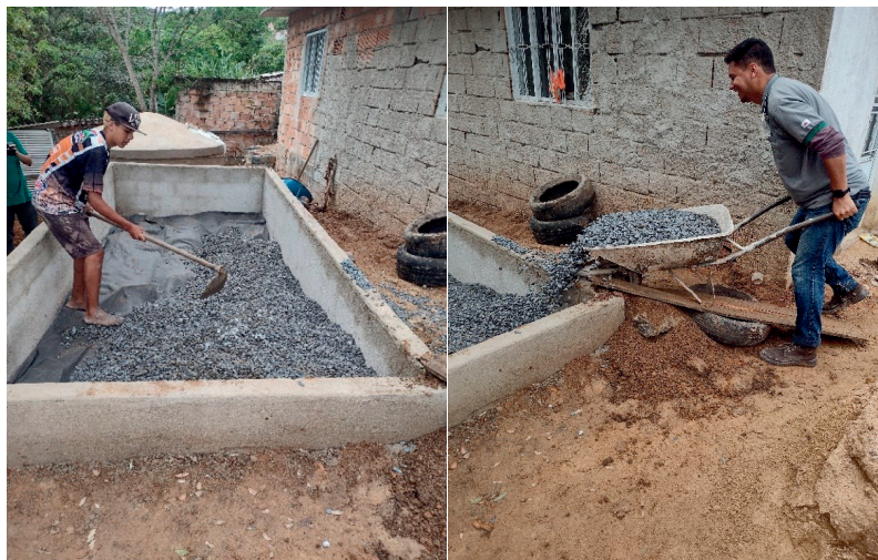
Fig. 12 – Adição da camada de brita no TEVap da Cozinha Comunitária como parte da oficina demonstrativa. Fonte: própria.
