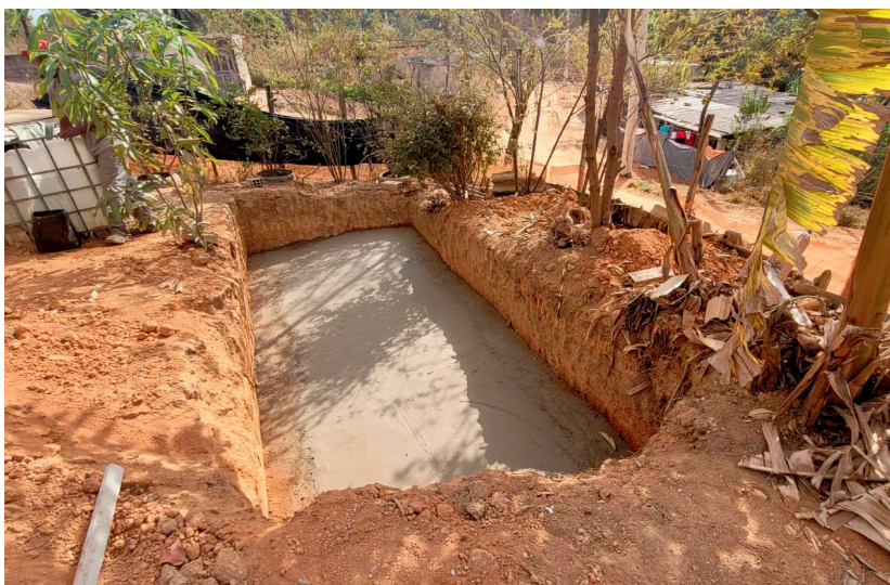
Fig. 7 - Vista da concretagem de fundo da fossa de um TEVap na rua Carolina de Jesus, Comunidade Vitória – Projeto Izidora. Fonte: MAIS AMBIENTE.
