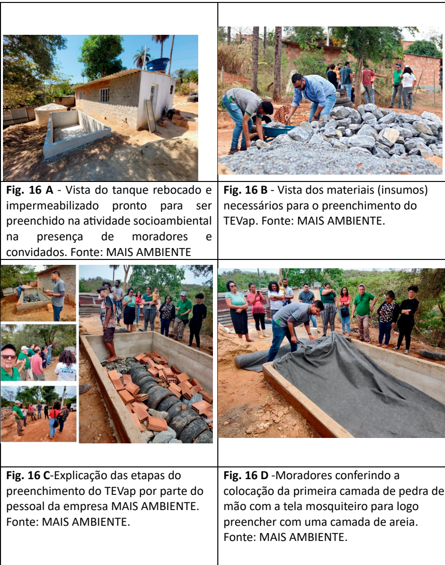
Fig. 16 – Algumas das etapas de adição de diferentes camadas em um TVAP cumpridas durante a atividade socioambiental realizada com os engenheiros da empresa contratada, moradores e convidados.
