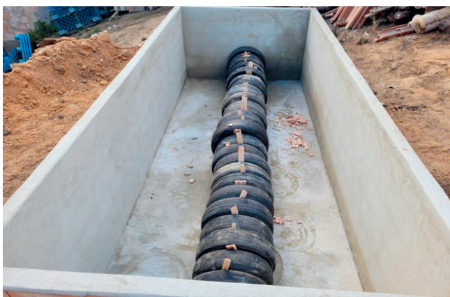
Fig. 10 - Instalação da câmara anaeróbia (câmara de pneus). Fonte: MAIS AMBIENTE.
