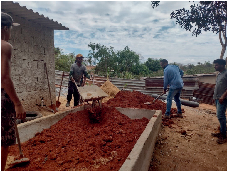
Fig. 14 – Adição da camada de solo orgânico no TEVap da Cozinha Comunitária como parte da oficina demonstrativa. Fonte: própria
