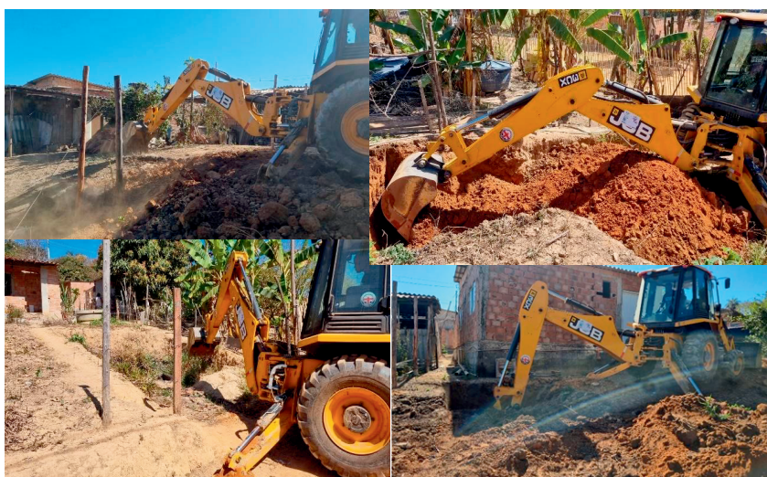
Fig. 6- Construção da fossa dos TEVap (2 x 1 x 4 metros) usando uma retroescavadeira. Fonte: MAIS AMBIENTE.
