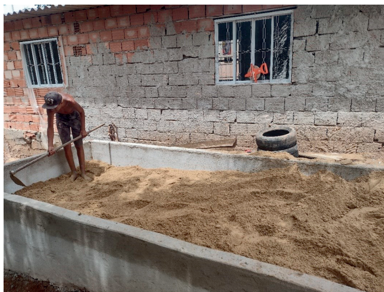
Fig. 13 – Adição da camada de areia no TEVap da Cozinha Comunitária como parte da oficina demonstrativa. Fonte: própria.
