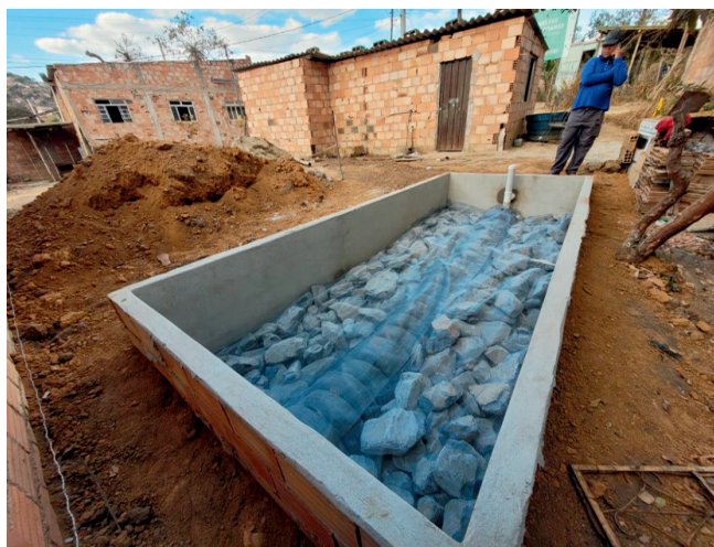
Fig. 11 - Preenchimento do TEVap com pedra de mão, instalação do piezômetro e da tela mosquiteiro. Fonte: MAIS AMBIENTE.
