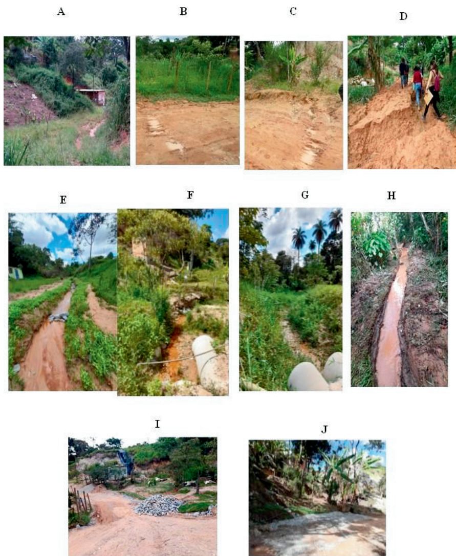
Fig. 4 - Nascente N1: Antes da intervenção: A: Nascente na rua correndo em diferentes direções (N1 A). B: Nascente aflorando na rua. C: Nascente aflorando na rua. D: Erosão (N1-A). Após da intervenção: E: Dreno recebendo água da nascente. F: Manilha antes da rua (N1-A). G: Nascente após a rua (N1-C). H: Dreno na N1-C. I e J: Aspecto da rua após intervenção.
