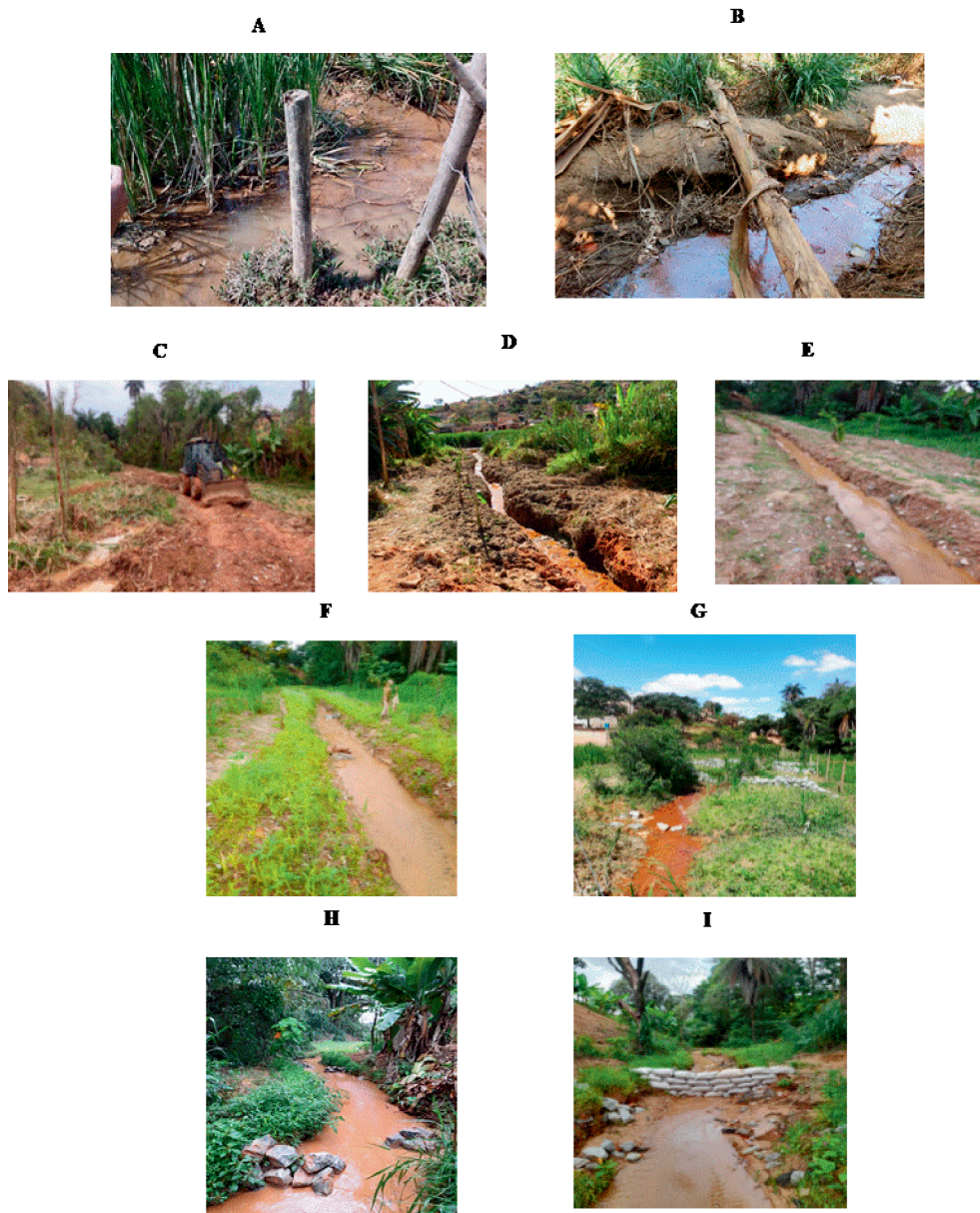
Fig. 5.1 - Nascente N2 A e B : Antes da intervenção (toda a área e ruas alagadas). C : Início da construção dos drenos. D e E : Drenagens. F : Plantio nas margens. G, H, I : Barreirinhas de contenção de sedimentos.
