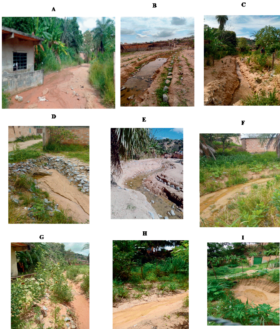
Fig. 7.2 - Nascente N4: Rua do Areal. A: Areal antes da intervenção. B e C: Abertura de drenos com estabilização com enrocamento e plantio, barreirinhas. D: Manilha. E e F: Estabilização mata miliar. G e H: Dreno estabilizado com mata ciliar, em 2024. I: Barragem.
