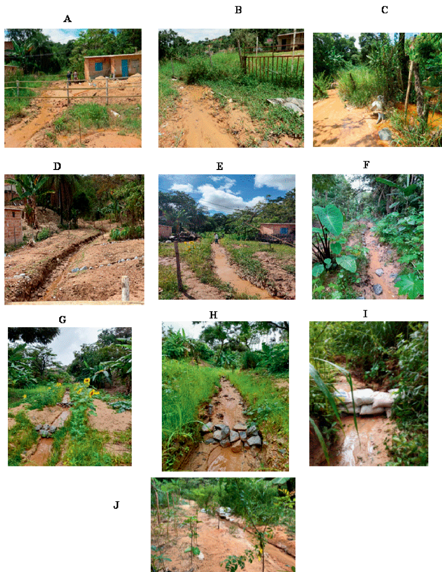
Fig. 6.1 - Nascente N3 A, B e C: Dreno na rua antes da intervenção. D: Abertura de dreno (550 m). E e F: Dreno em funcionamento com plantio de herbáceas nas margens, G H e I: Barreirinhas de Contenção (2022). J: Espécies arbóreas plantadas, aos 6 meses e Barreirinhas (outubro de 2023).
