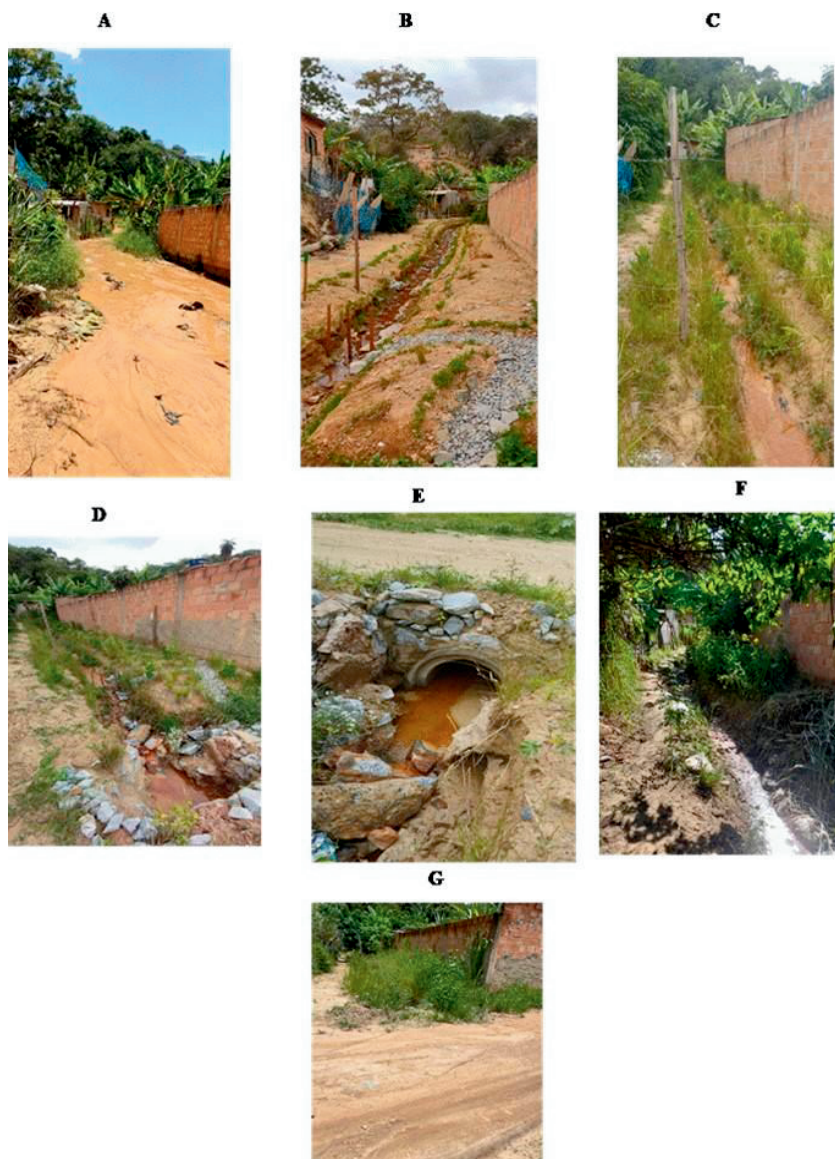
Fig. 7.1 - Nascente N4 - Rua das Águas e Av. Vitória A: Rua das Águas e Av. Vitória, mostrando as áreas inundadas, antes da intervenção. B e C: Dreno com estabilização com plantio e barreirinhas. D e E: Drenagem com manilha e proteção com enrocamento. F: Rua das Águas em janeiro de 2024, G: Rua das Águas e Av. Vitória em janeiro de 2024 (comparar com Fig. 7.1 A ).
