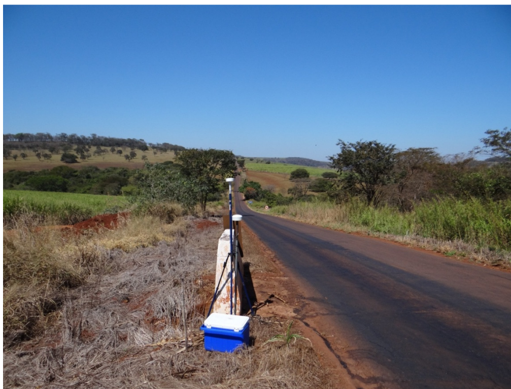
Fig. 36 – Pequeno pontilhão na subida da BR 464, logo após a ponte no fundo do vale, lado direito sentido BR 050. Data de aquisição: 09/08/2012, hora: 12:47 h.
