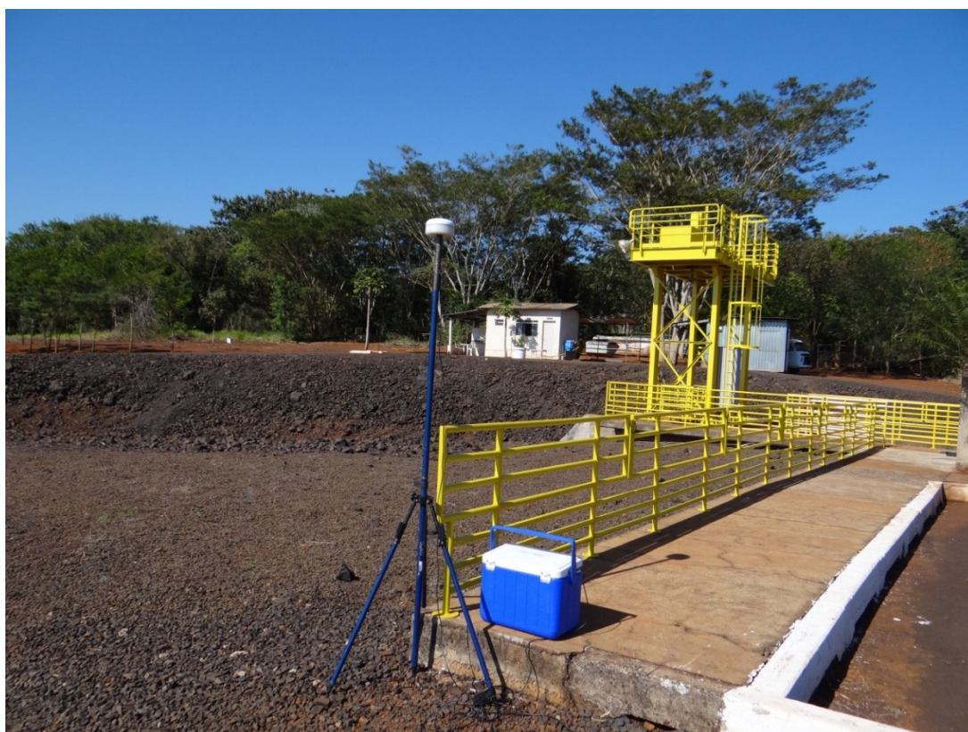
Fig. 05 – Grade amarela junto à barragem da UHE Igarapava. Data de aquisição: 07/08/2012; hora: 09:57 h.
