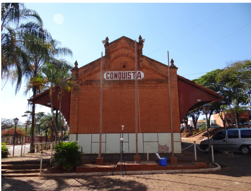
Fig. 32 – Antiga estação ferroviária de Conquista (MG) na praça em frente a Câmara de Vereadores da mesma cidade. Data de aquisição: 08/08/2012, hora: 14:02 h.
