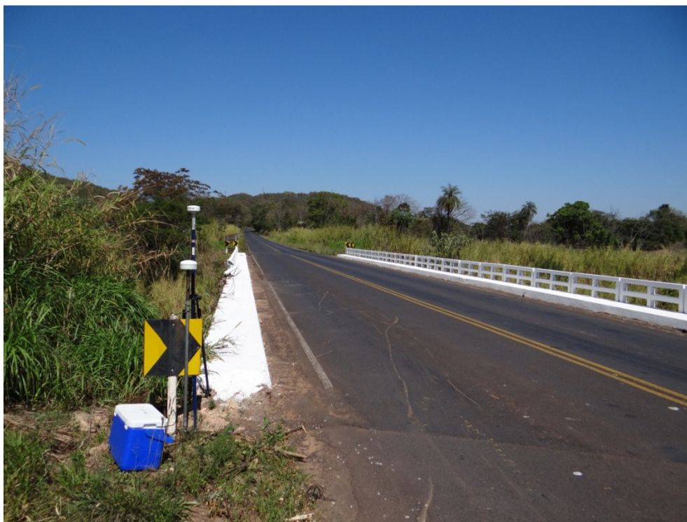
Fig. 26 – Ponte sobre ribeirão Cana Brava. Data de aquisição: 08/08/2012, hora: 12:11 h.
