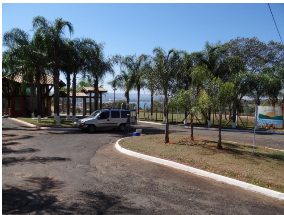
Fig. 21 – Portaria do condomínio “Residencial Morada da Fronteira” junto a estrada intermunicipal Igarapava (SP)- Rifaina (SP). Data de aquisição: 08/08/2012; hora: 10:36 h.
